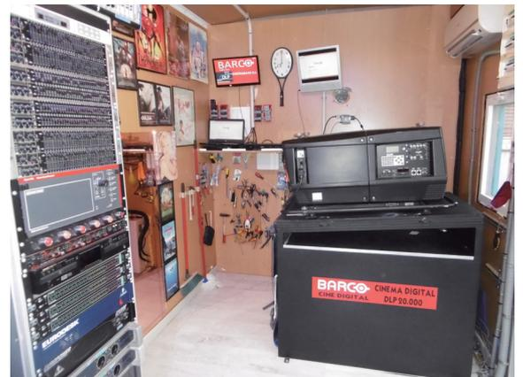
PROYECTOR BARCO DLP Y RACK DE SONIDO DE 40.000 WATIOS, MESA MEZCLADORA DE 32 CANALES Y MICROFONIA INHALAMBRICA
